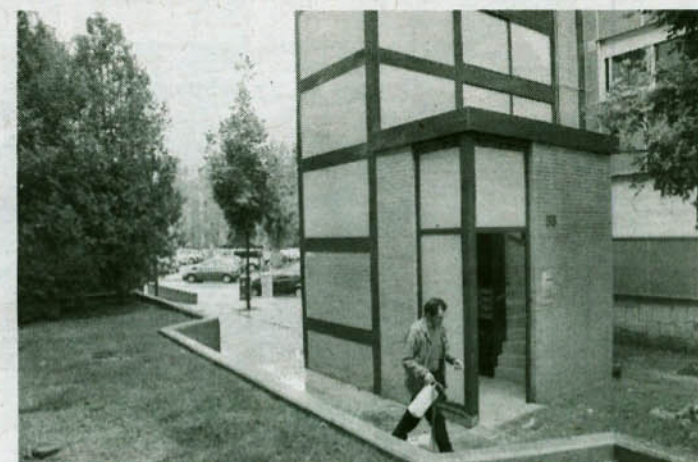
Instalación de ascensores en bloques antiguos de Sant Llorenç.
